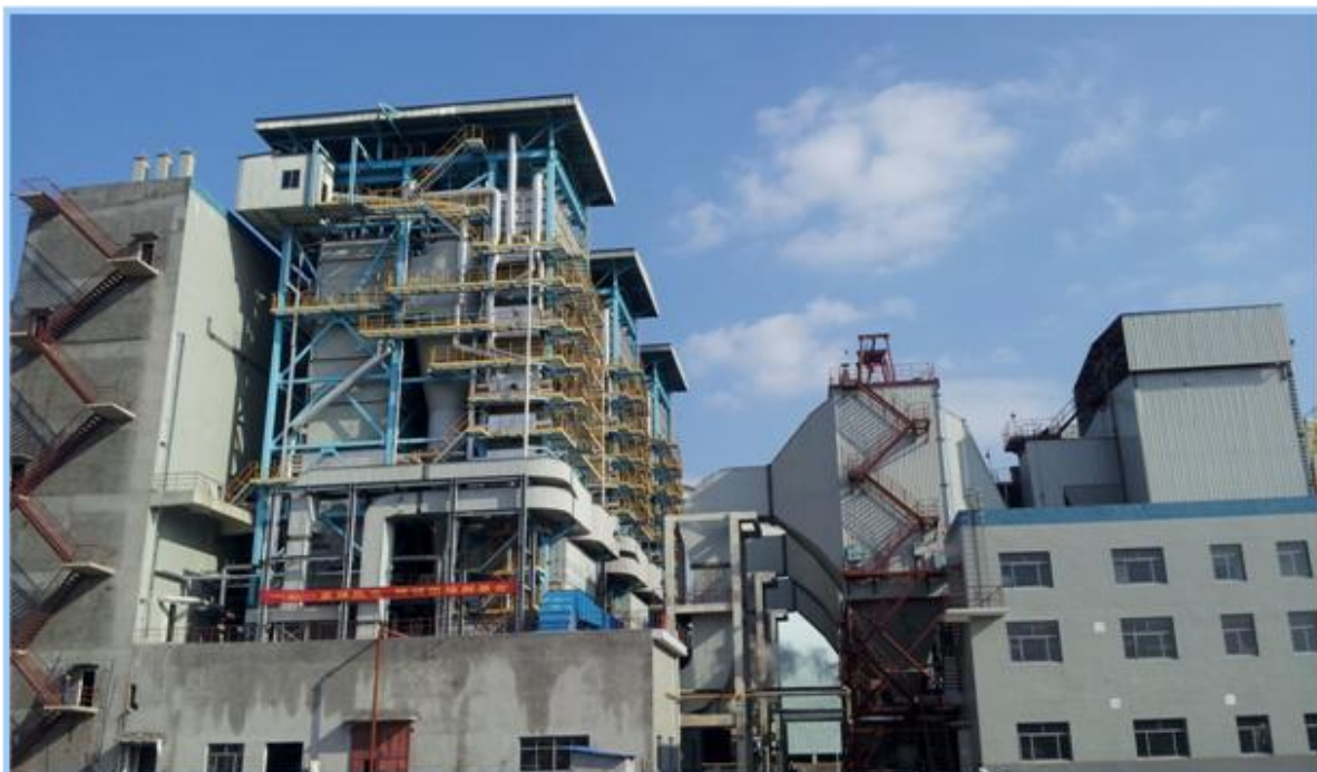
丽水市杭丽热电有限公司 3 × 130t/h-9.8 CFB 锅炉 (2011-06-20签订)
