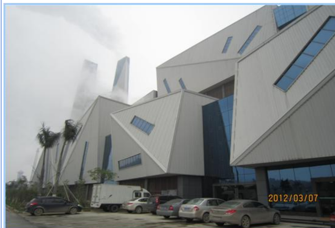
佛山市南海绿电再生能源有限公司 3 × 500t/d垃圾焚烧余热锅炉 (2008-12-25签订)
