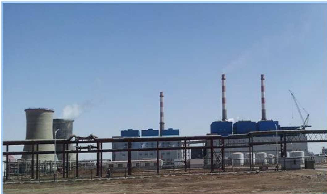
青海盐湖集团二期1 × 480t/h-9.8 CFB 锅炉
