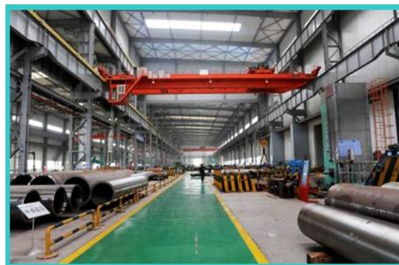
核电分厂现场
