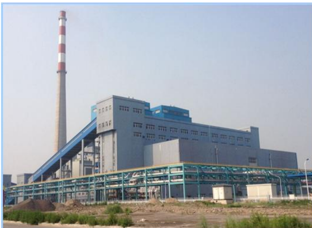
唐山中浩化工有限公司2 × 240t/h-9.8 CFB 锅炉 (2014-06-23摄)
